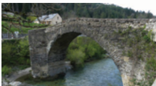
km 98 Pont de Barre
