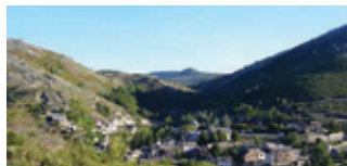
km 58 Le Pont-de-Montvert Sud-Mont-Lozère
